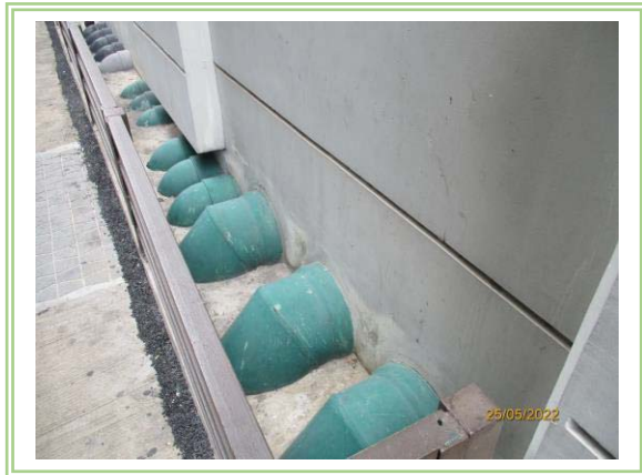
รูปที่ 2.5-4 ระบบระบายน้ำฝนของอาคาร
